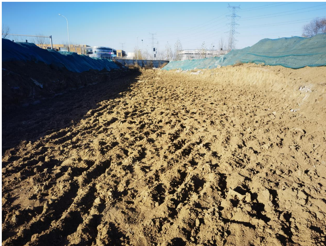
图七 项目现场照 4
